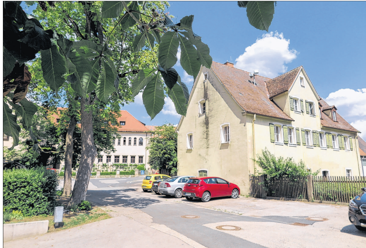
Viele Jahre diente das frühere Infirmatorium des Klosters Heilsbronn als Mesnerhaus. Heute steht das denkmalgeschützte Gebäude leer. Es könnte zum attraktiven KunstRaum werden, meint Gerhard Spangler. Foto: Eckard Dürr
